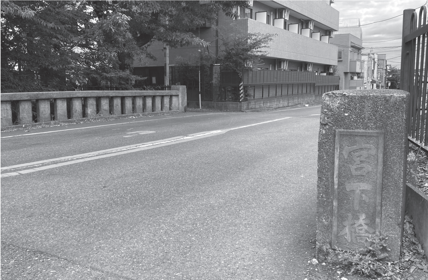
安全性と利便性の向上を目的として、架け替え工事が予定されている宮下橋
