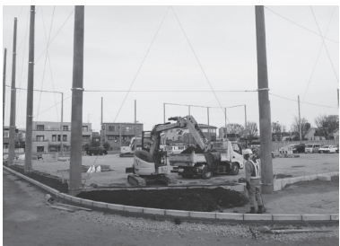
整備が進む井口グラウンド
