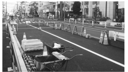
三鷹都市計画道路3・4・7号(連雀通り)の工事の様子
