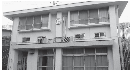
耐震補強工事が予定されている井の頭東部地区公会堂
