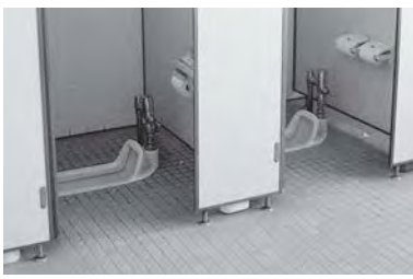
改修工事が実施される第六小学校のトイレ
