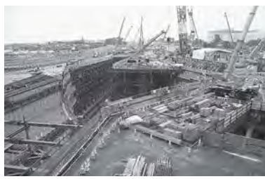
東京外郭環状道路工事現場(中央ジャンクション)
