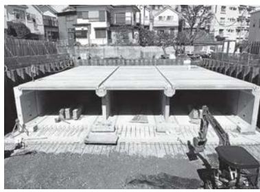
整備が進む中仙川雨水貯留施設
