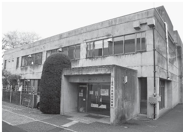
旧三鷹市第二体育館
