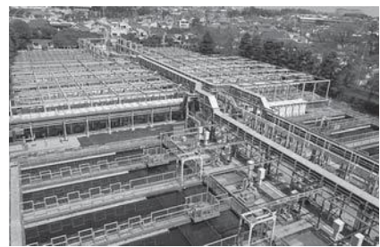
東部水再生センター
