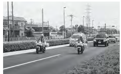
開通した三鷹都市計画道路 3・2・2号
