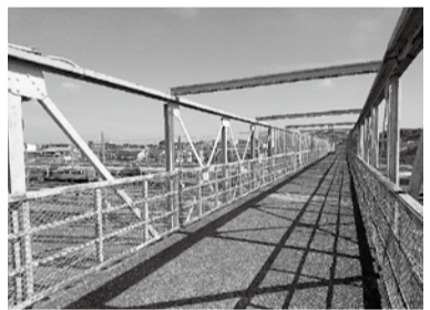
三鷹電車庫跨線橋
