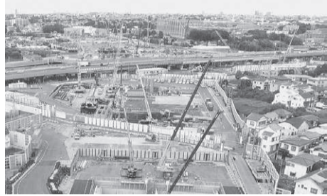
工事が進む中央ジャンクション（仮称）
