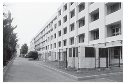
耐震補強工事済の第一中学校
