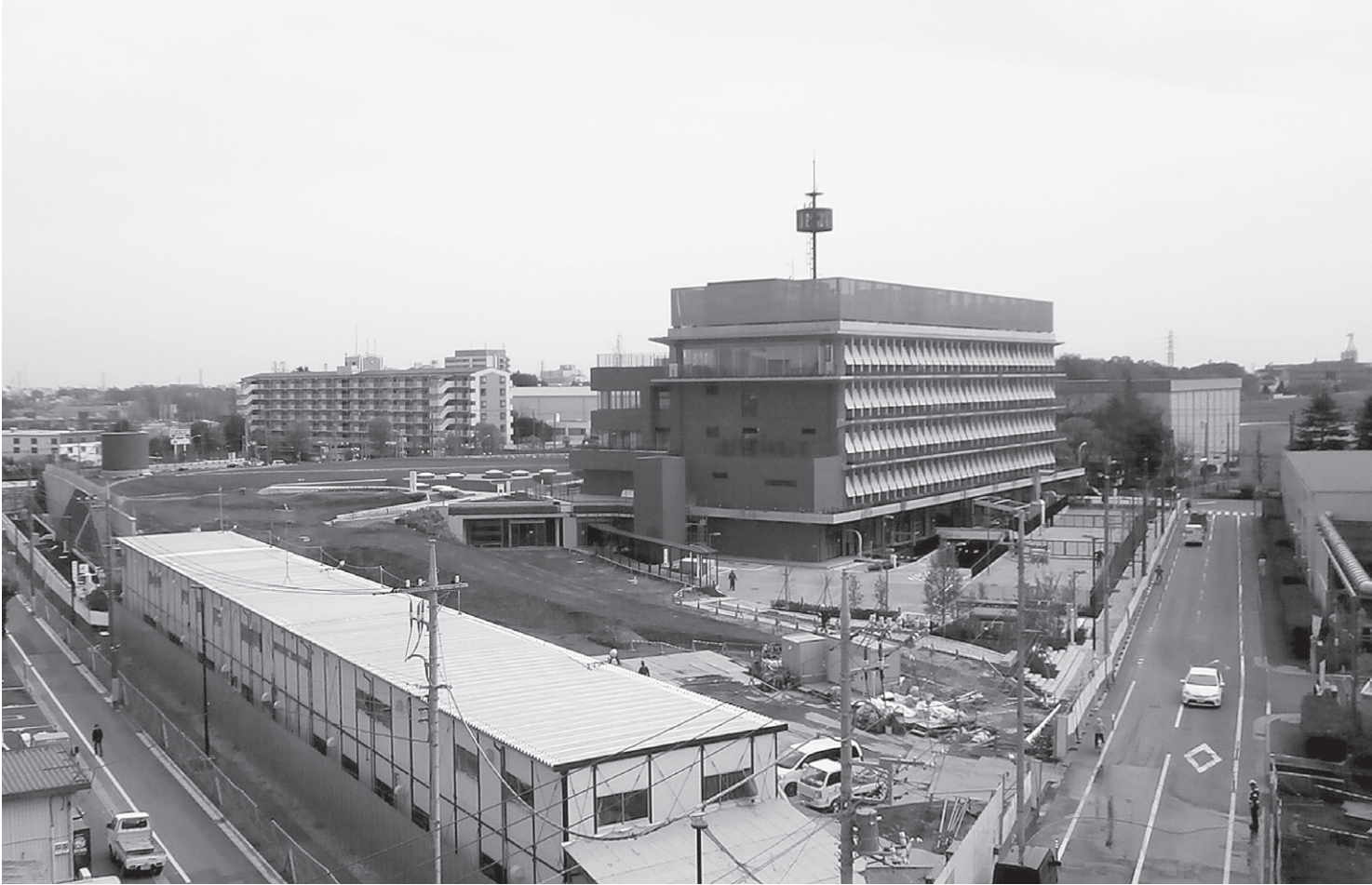
平成29年4月のオープンに向けて建設工事が進む、三鷹中央防災公園・元気創造プラザ（新川六丁目）
