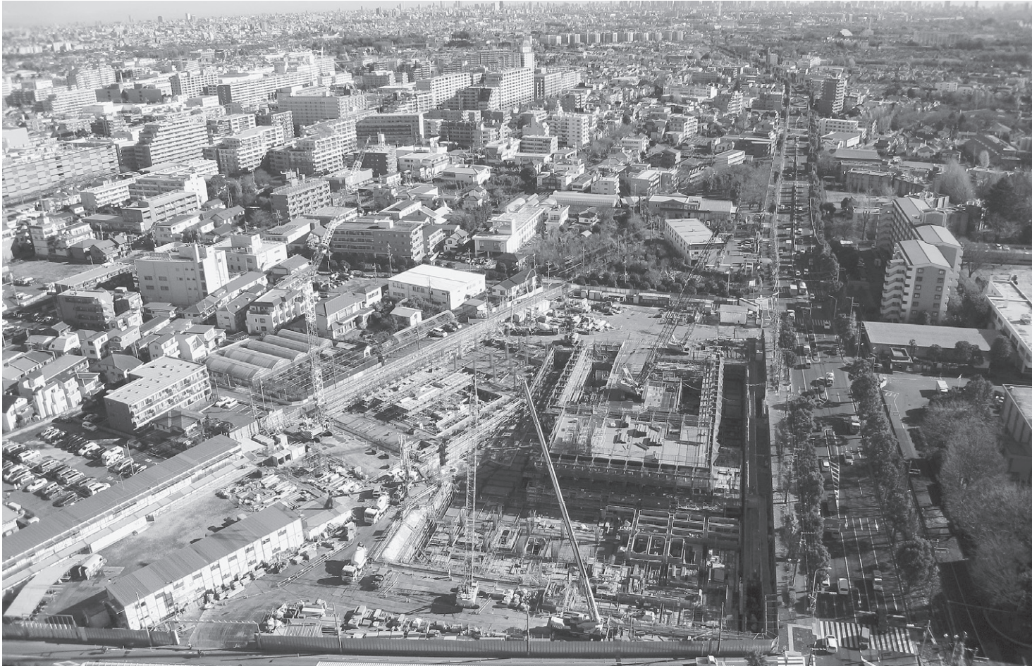
平成28年度の竣工を目指して、建設工事が進む新川防災公園・多機能複合施設（仮称）（新川六丁目）
