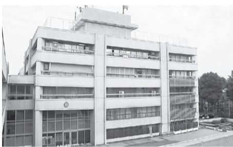
照明のLED化を実施する市役所本庁舎
