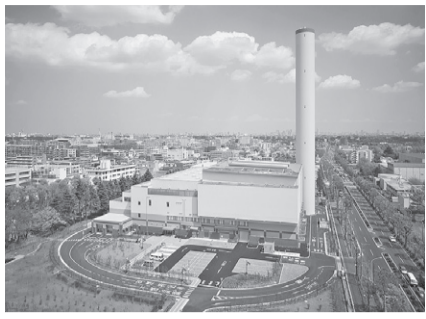
クリーンプラザふじみ
