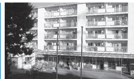
建て替えを行う南浦西保育園
