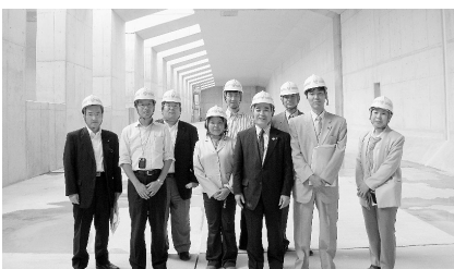
東京外郭環状道路国分堀削部試験工 事現場(千葉県市川市)
