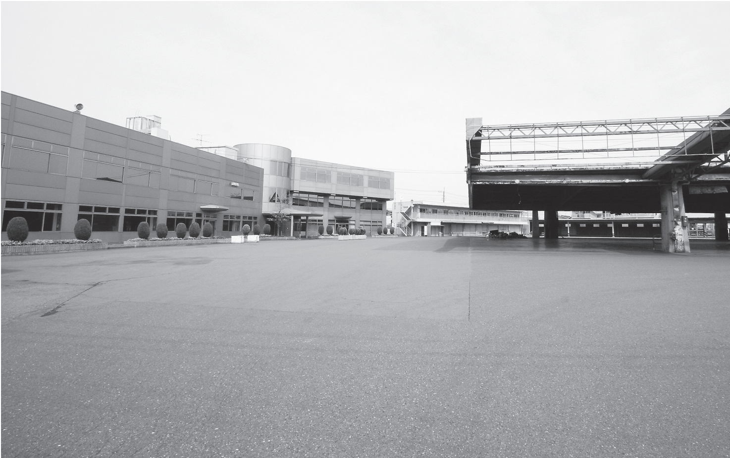
跡地の利活用については、総合的かつ長期的な視点で協議を進めてほしい ……市庁舎に隣接する多摩青果（三鷹市場）跡地
