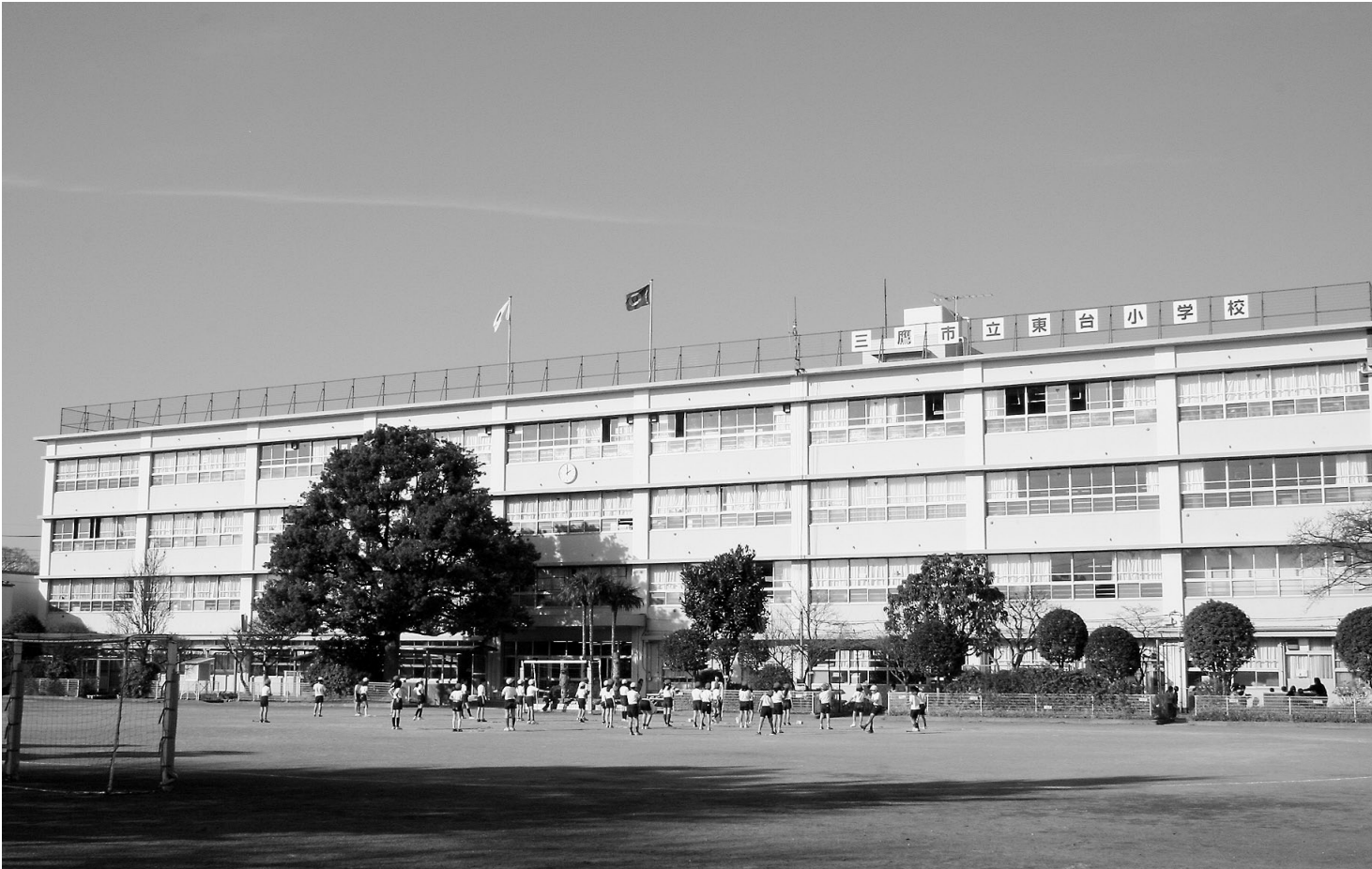
バリアフリー化や防災機能の強化なども視野に入れ学校の耐震化を進めてほしい ……校舎の建て替えが予定されている東台小学校
