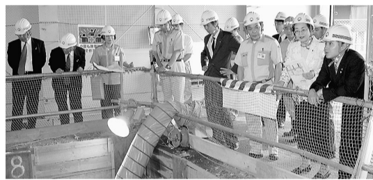
推進工法による水道工事の視察 …人見街道（市役所前）
