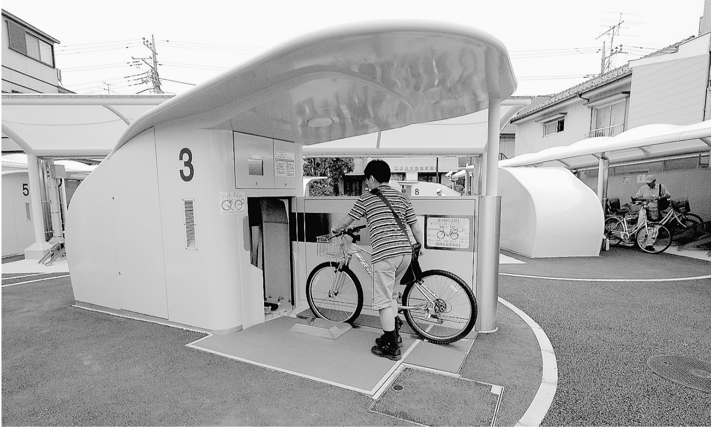
駐輪場不足の解消で市民の利便性の向上と三鷹駅前地区の活性化が期待される ……7月1日にオープンしたすずかけ駐輪場（地下1440台、地上260台、合計1700台収容可能な機械式立体駐輪場）
