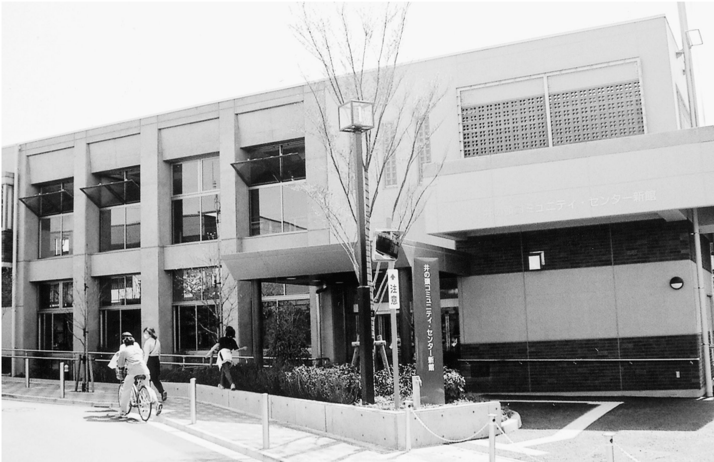
スポーツ、音楽活動の他に、災害時には避難活動の中心拠点となる …新しくオープンした井の頭コミュニティ・センター新館
