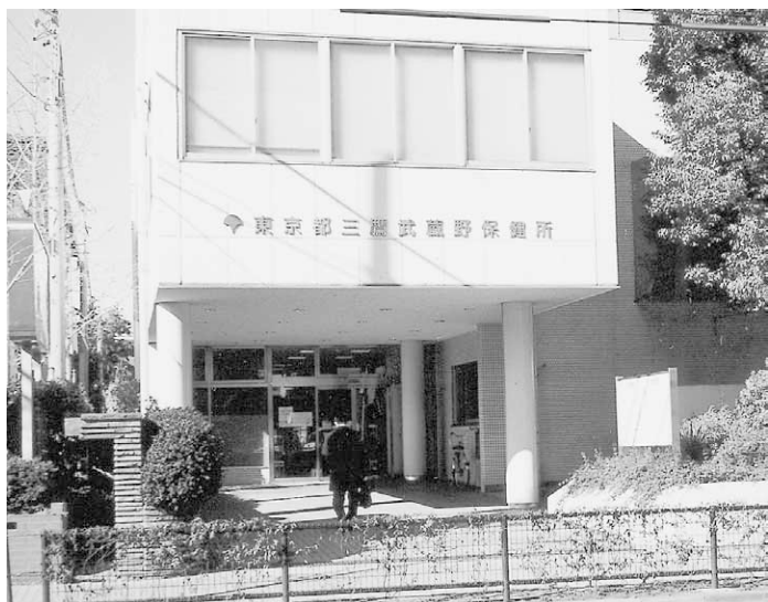
多摩地域における保健医療体制のあり方が問われている ……三鷹武蔵野保健所
