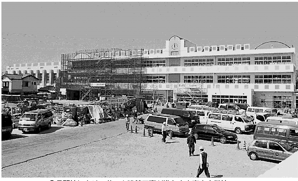
9月開校に向け、着々と建替工事が進む市立高山小学校
