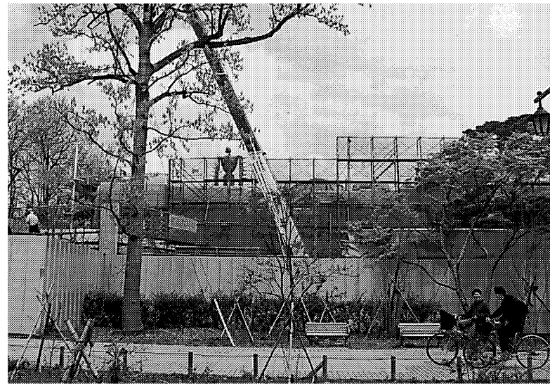
今年10月のオープンに向け、順調に工事が進む市立アニメーション美術館 ……都立井の頭恩賜公園西園
