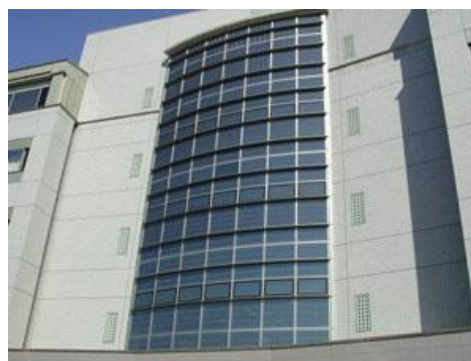
「シースルーアモルファス太陽電池」を組み込んだ太田市庁舎の窓ガラス(太田市ホームページより)
