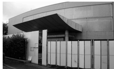
大規模改修工事が実施されている旧どんぐり山施設
