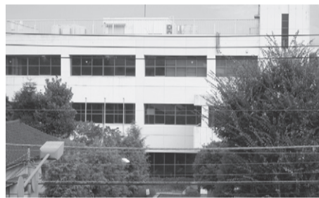
耐震補強等工事を行う教育センター
