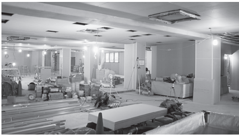
内装工事が進む三鷹市立南部図書館
