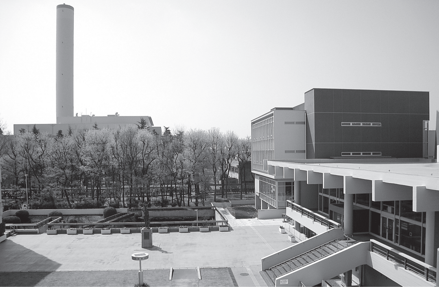
4月に本格稼働を開始した「クリーンプラザふじみ」と3月にリニューアルオープンした「三鷹市公会堂」
