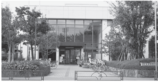
三鷹市立三鷹図書館（本館）
