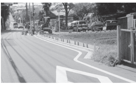
車両の退避場所（東台小入口付近）
