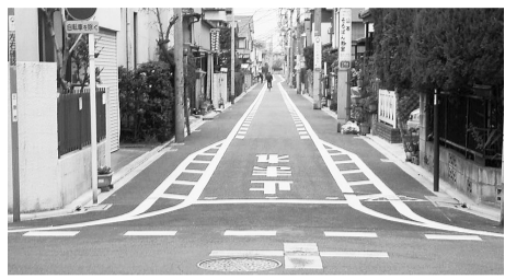
歩行者優先の道路行政を進めてほしい…「あんしん歩行エリア」整備後の道路
