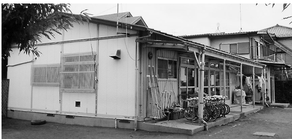
小学校の敷地内に移設される北野小学童保育所
