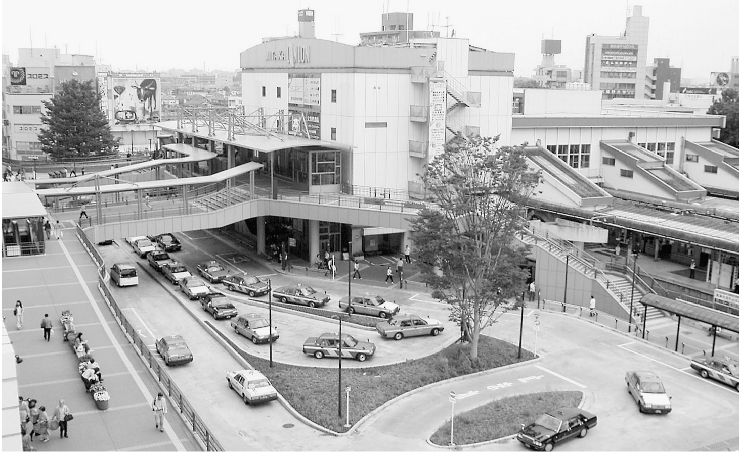
市の表玄関として、三鷹駅前地区の活性化などに大きな役割が期待される ……第2期整備事業が完了した三鷹駅南口駅前広場
